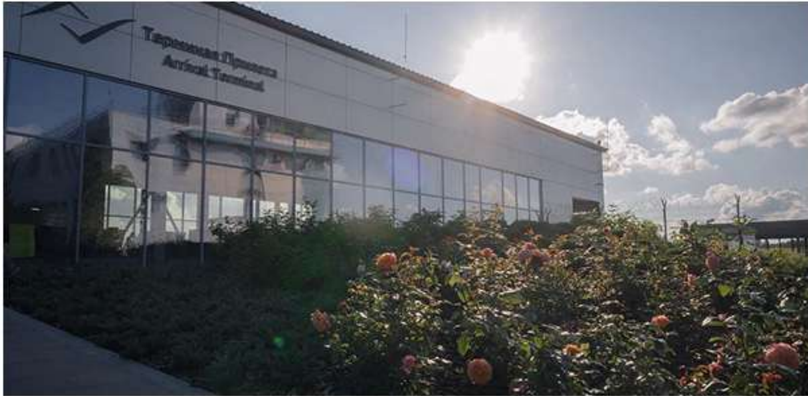
Терминал аэропорта Горно-Алтайск
